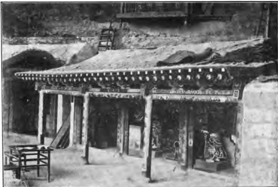
4. La chapelle centrale et les échelles menant à la plate-forme supérieure.
